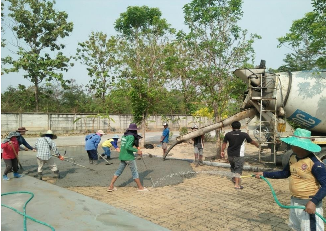
ใช้ ซี-แพค เทถนนคอนกรีต
