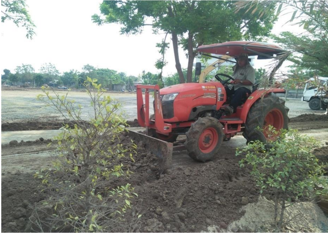
ปรับพื้นที่ทำถนนคอนกรีต
