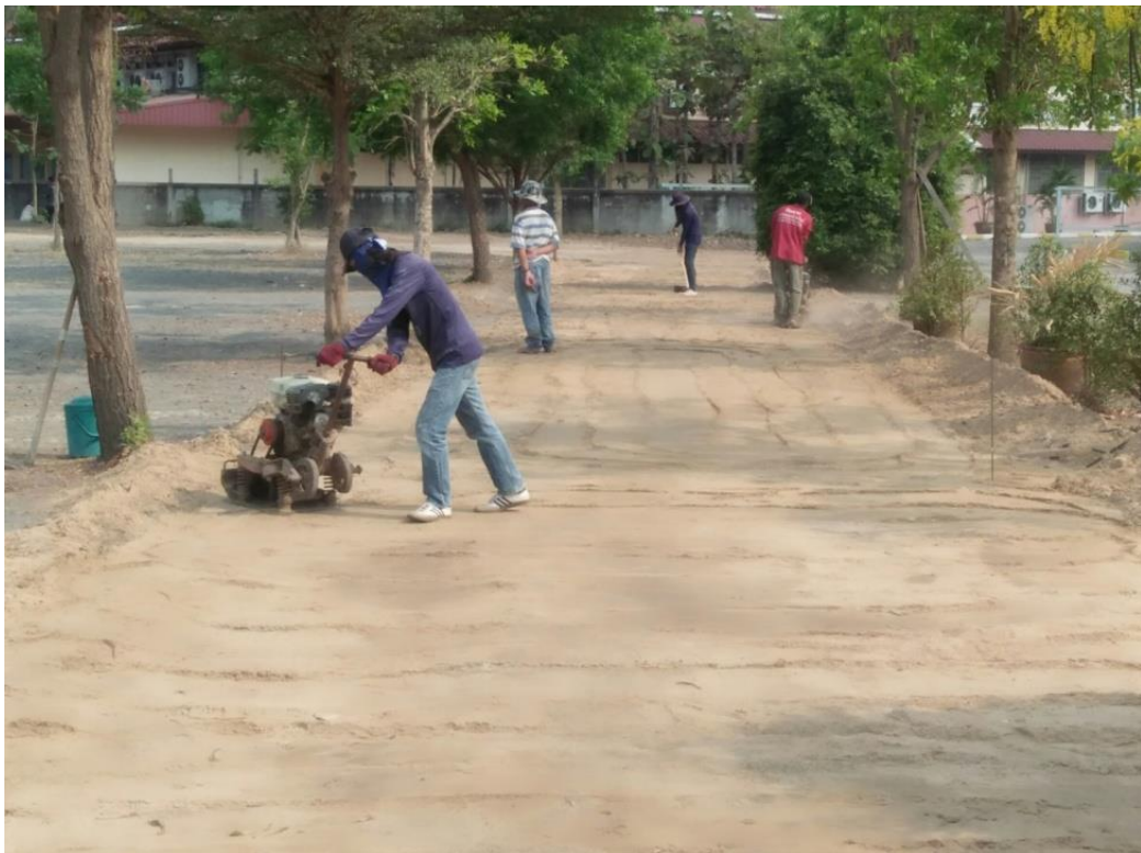
ปรับพื้นที่เททรายและอัดพื้นเตรียมเทคอนกรีต
