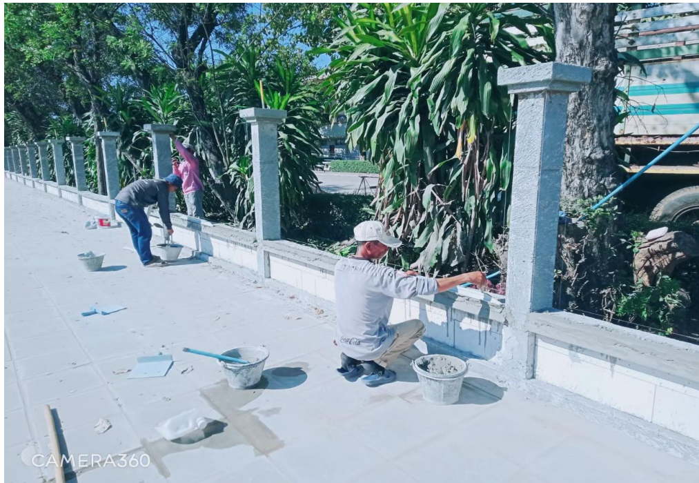
ซ่อมแซมกำแพงหน้าโรงเรียนมารีย์อนุสรณ์
