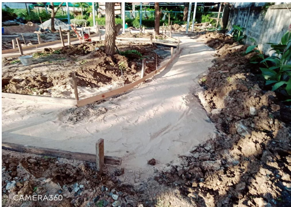
ปรับพื้นที่สร้างสวนวรรณคดีของโรงเรียนมารีย์อนุสรณ์
