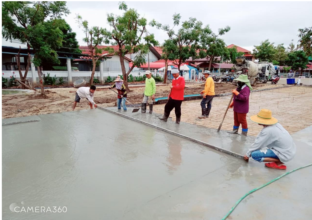
สร้างลานจอดรถ หลังโรงเรียนมารีย์อนุสรณ์
