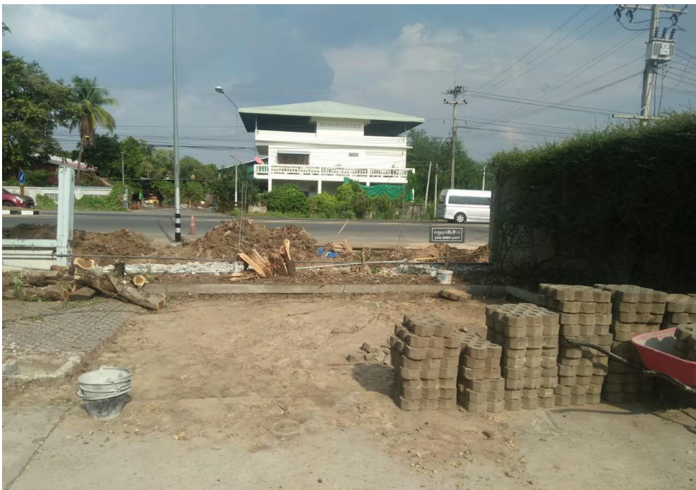
วางท่อและปรับบริบทหน้าโรงเรียนมารีย์อนุสรณ์
