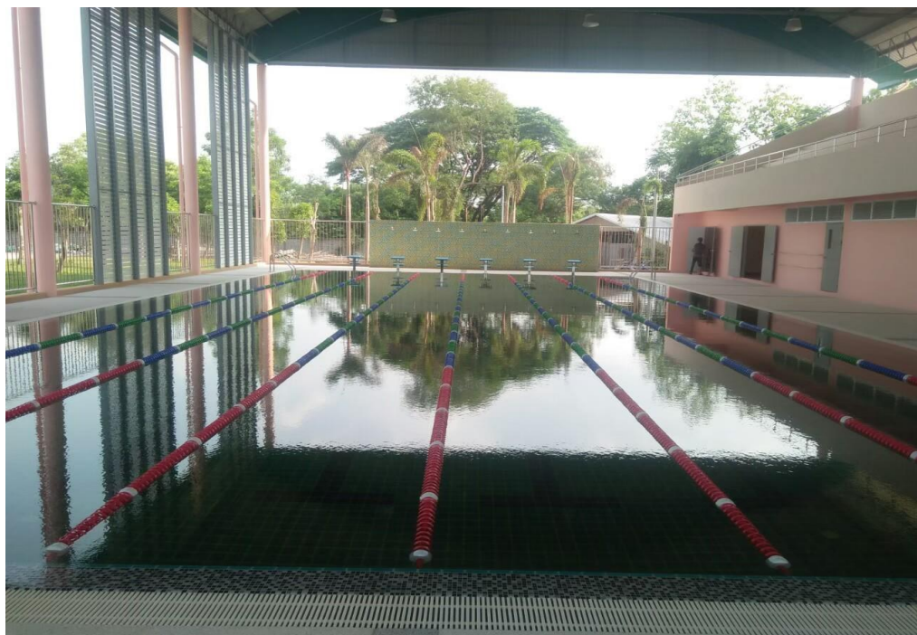
สร้างสระว่ายน้ำ และแล้วเสร็จพร้อมใช้ ในปีการศึกษา 2563
