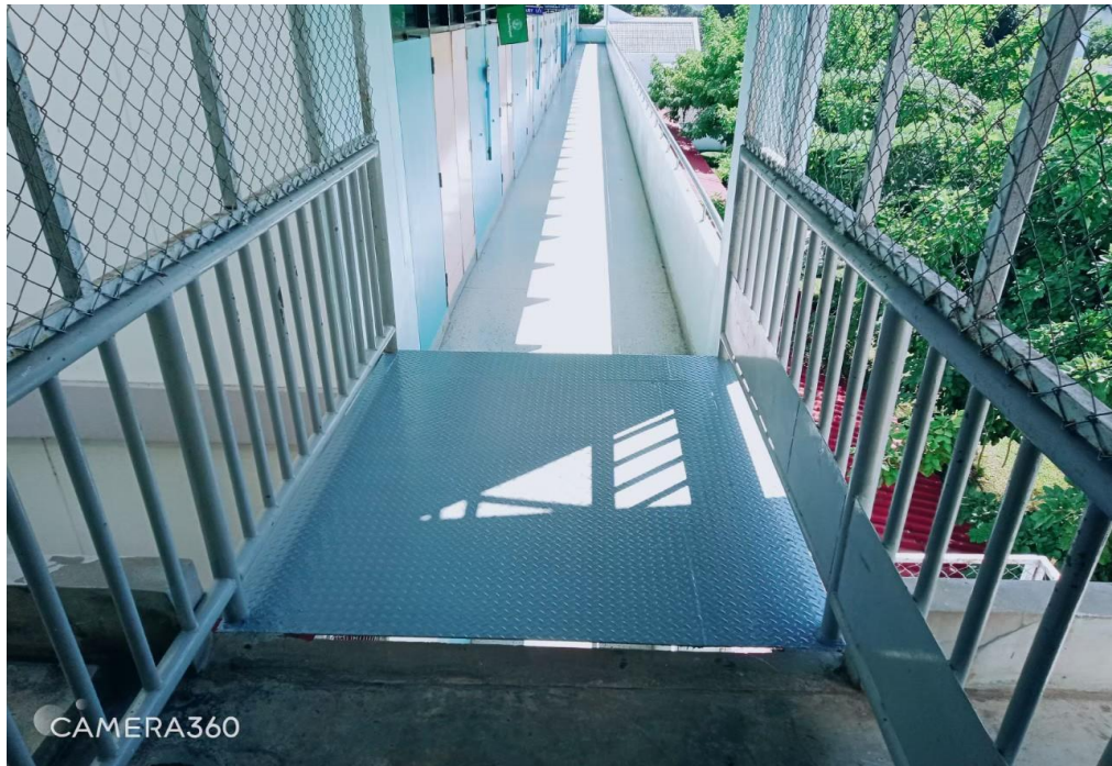
ซ่อมแซมทางเดินระหว่างอาคาร
