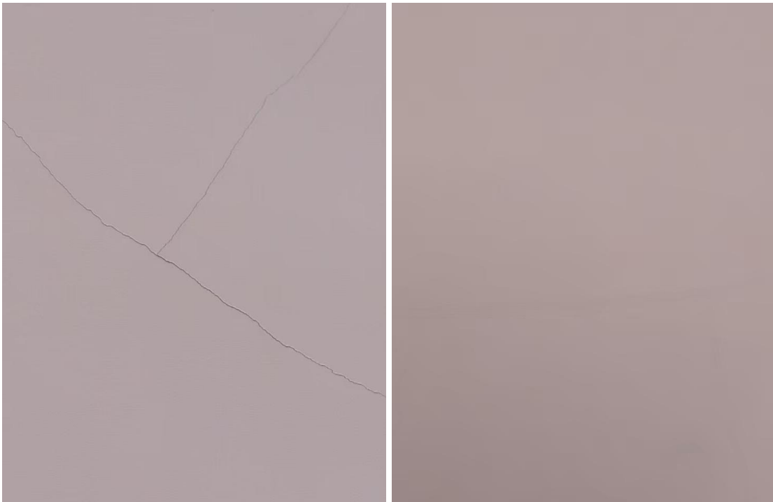
ซ่อมแซมอาคารหรือห้องเรียนที่มีปัญหาต่างๆ
