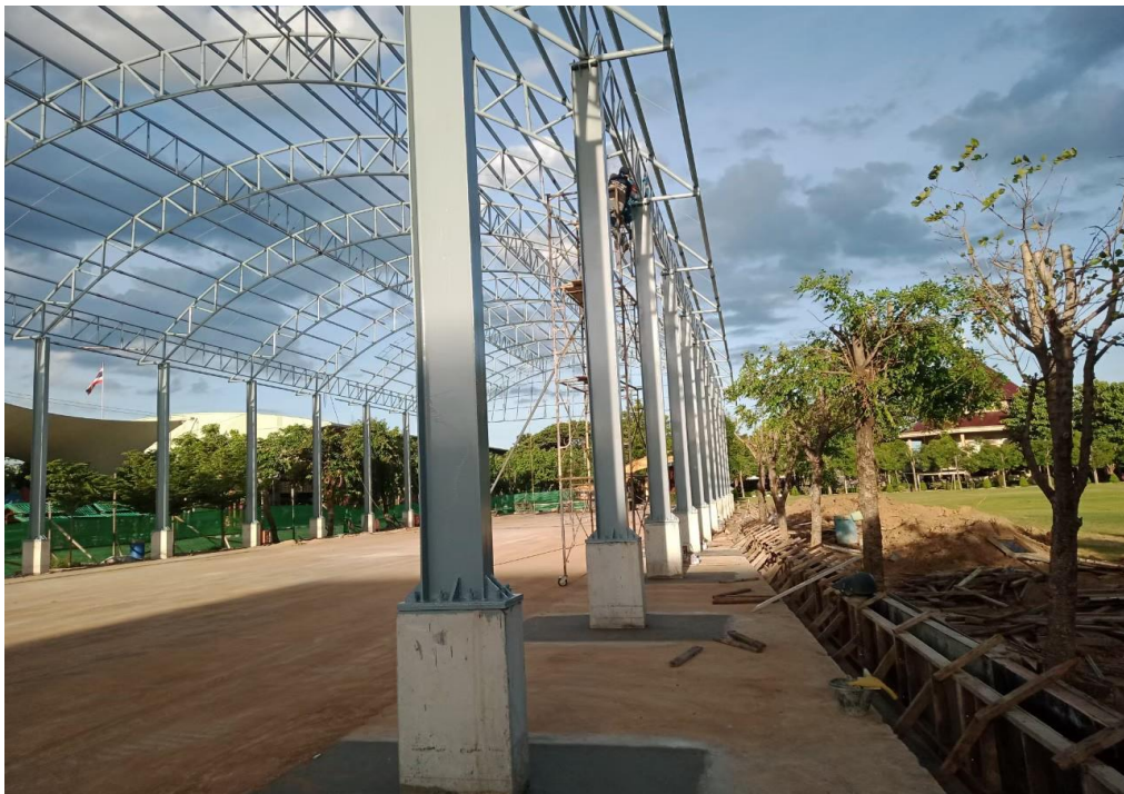
การก่อสร้างโดม เซนต์ปีเตอร์โดม ใหม่ของโรงเรียนมารีย์อนุสรณ์
