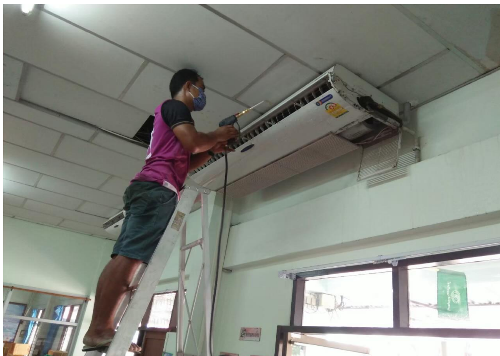
ซ่อมบำรุงเครื่องปรับอากาศ
