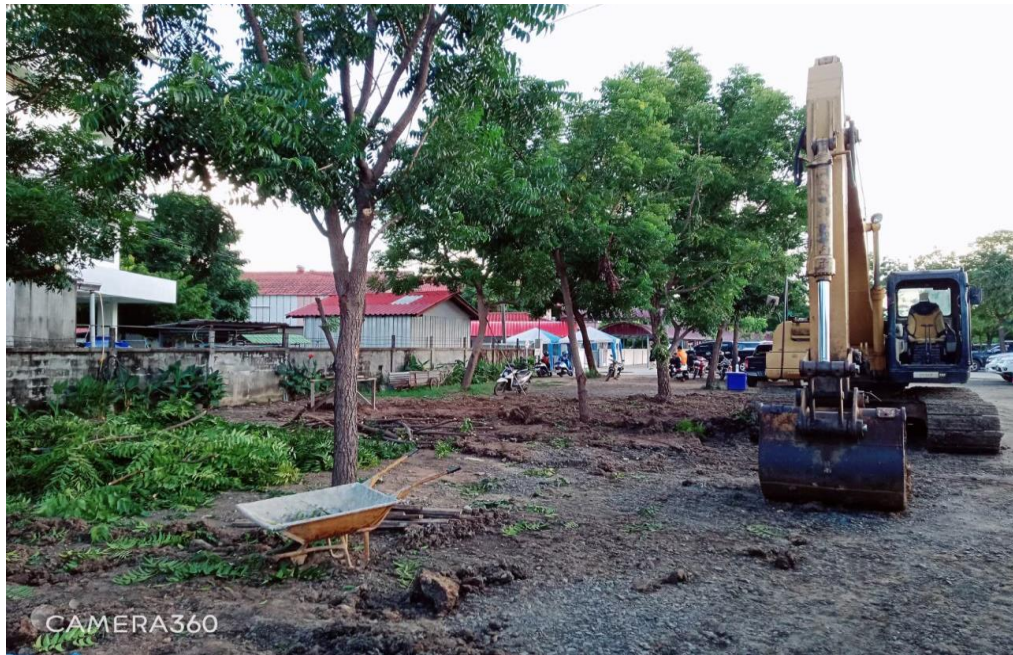
ปรับพื้นที่สร้างสวนวรรณคดีของโรงเรียนมารีย์อนุสรณ์
