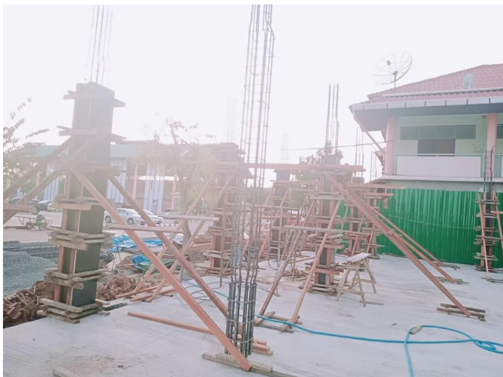
ดำเนินการก่อสร้างตีกอนบูล
