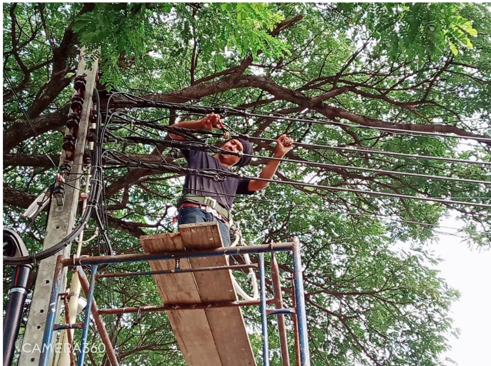
ซ่อมแซมสายไฟฟ้า
