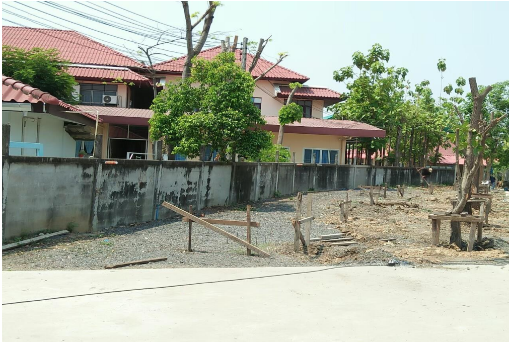
สร้างหลังคาทางเดินเท้าไปสระว่ายน้ำ
