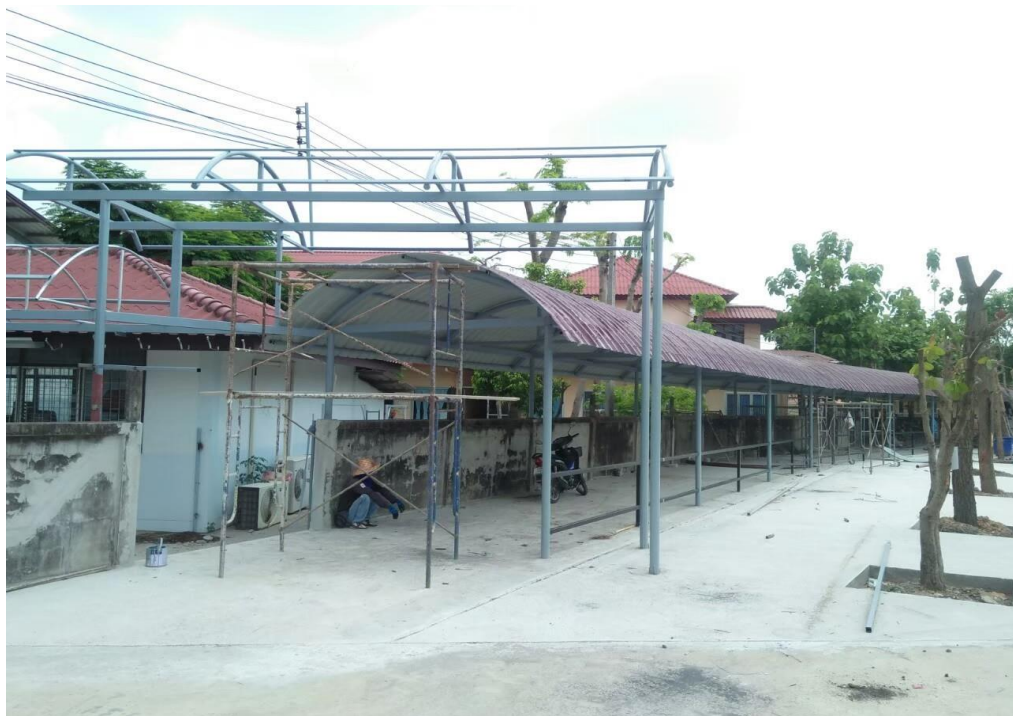
สร้างหลังคาทางเดินเท้าไปสระว่ายน้ำ
