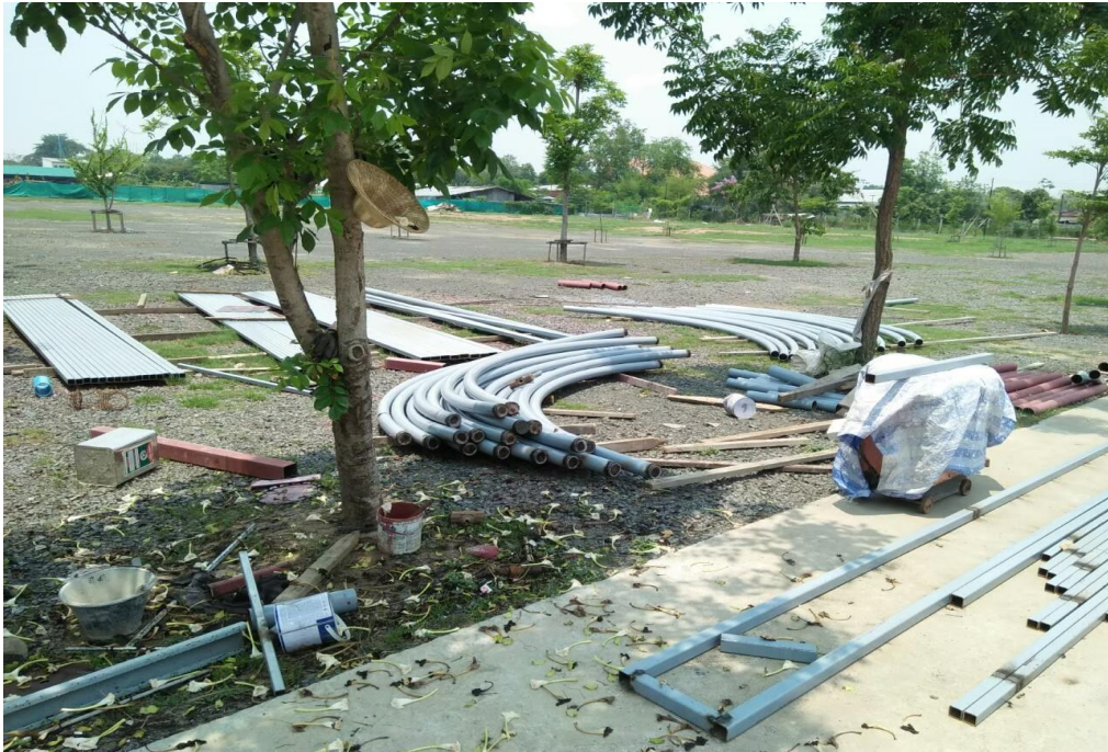
อุปกรณ์สร้างหลังคาทางเดินเท้า
