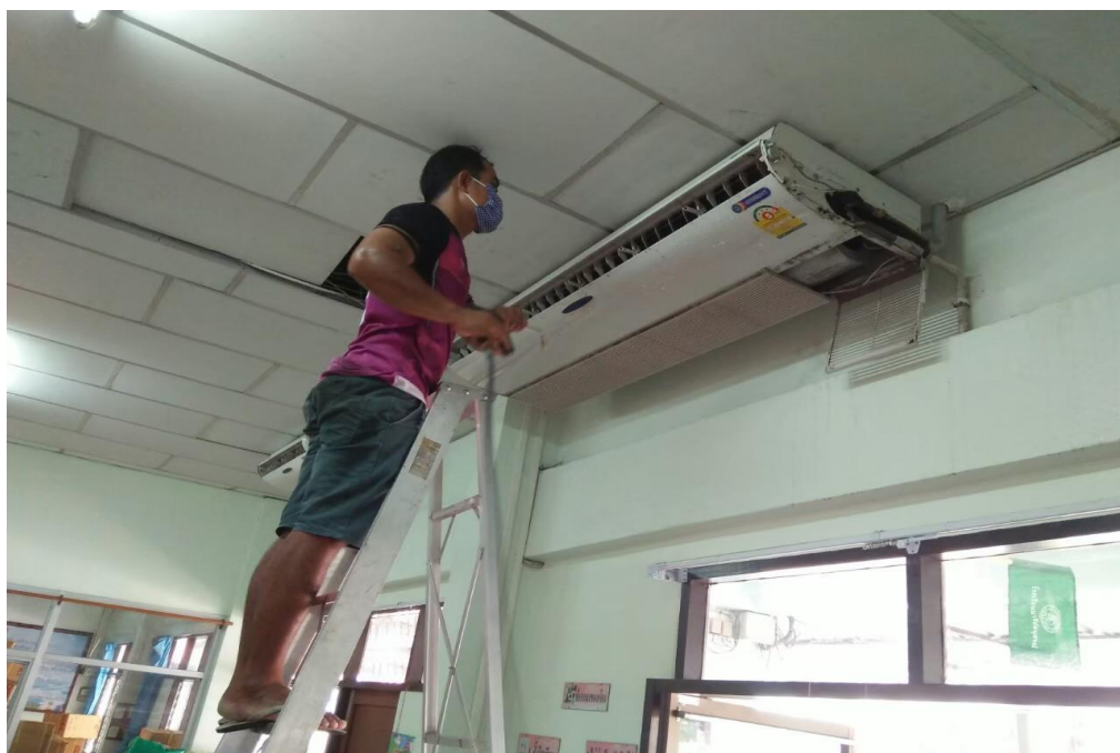
ซ่อมบำรุงเครื่องปรับอากาศ
