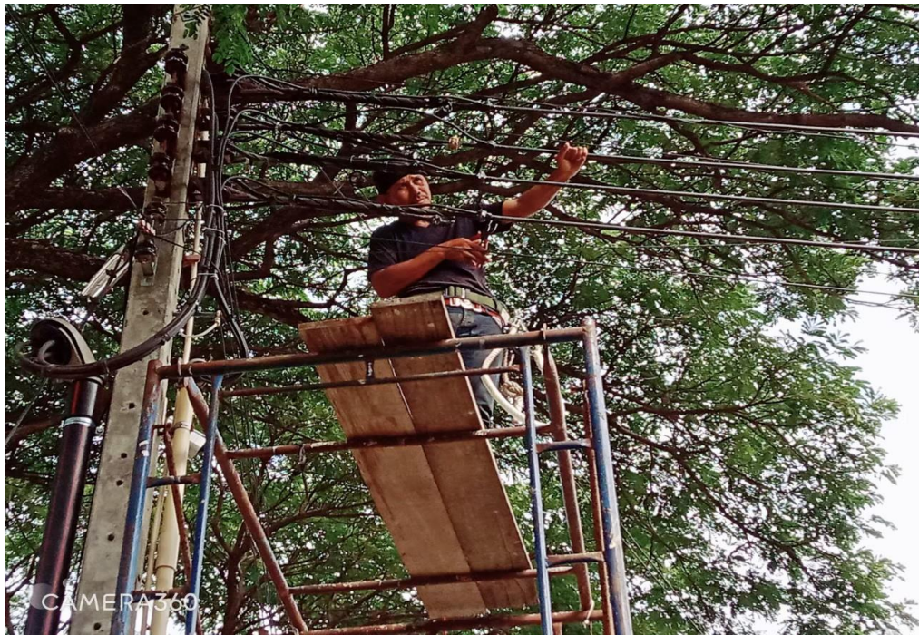
ซ่อมแซมสายไฟฟ้า
