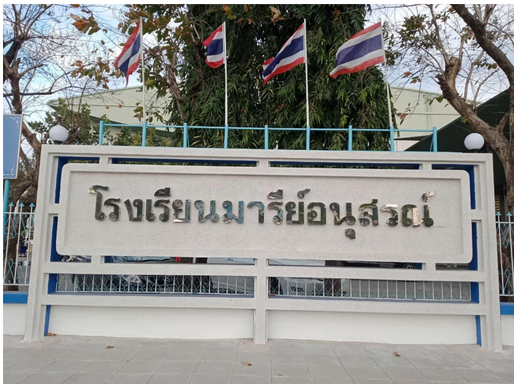
ซ่อมบำรุงป้ายโรงเรียนมารีย์อนุสรณ์
