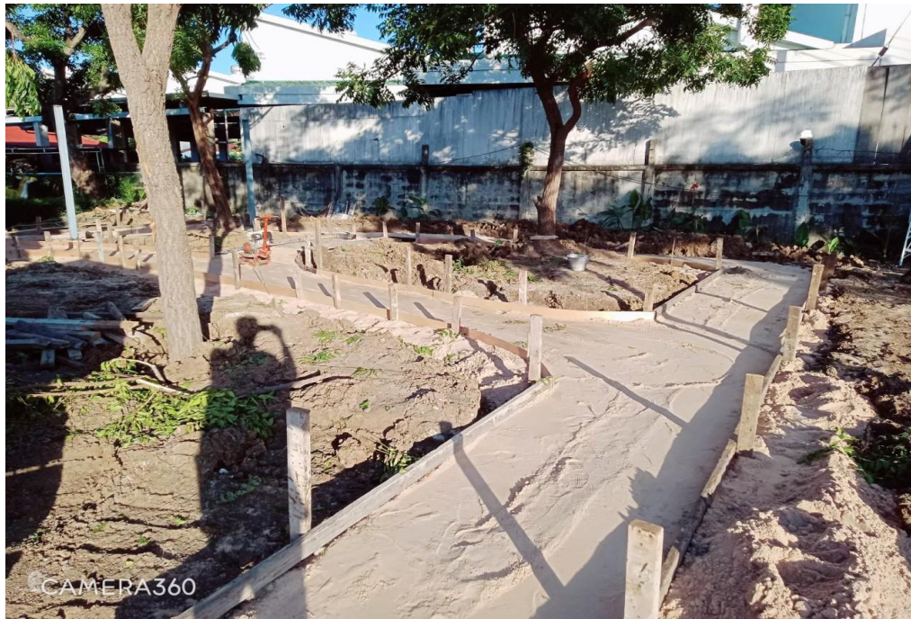
ปรับพื้นที่สร้างสวนวรรณคดีของโรงเรียนมารีย์อนุสรณ์
