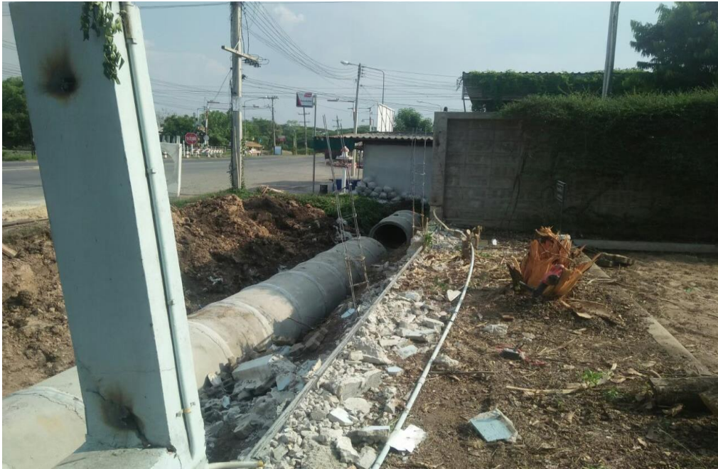
วางท่อและปรับบริบทหน้าโรงเรียนมารีย์อนุสรณ์
