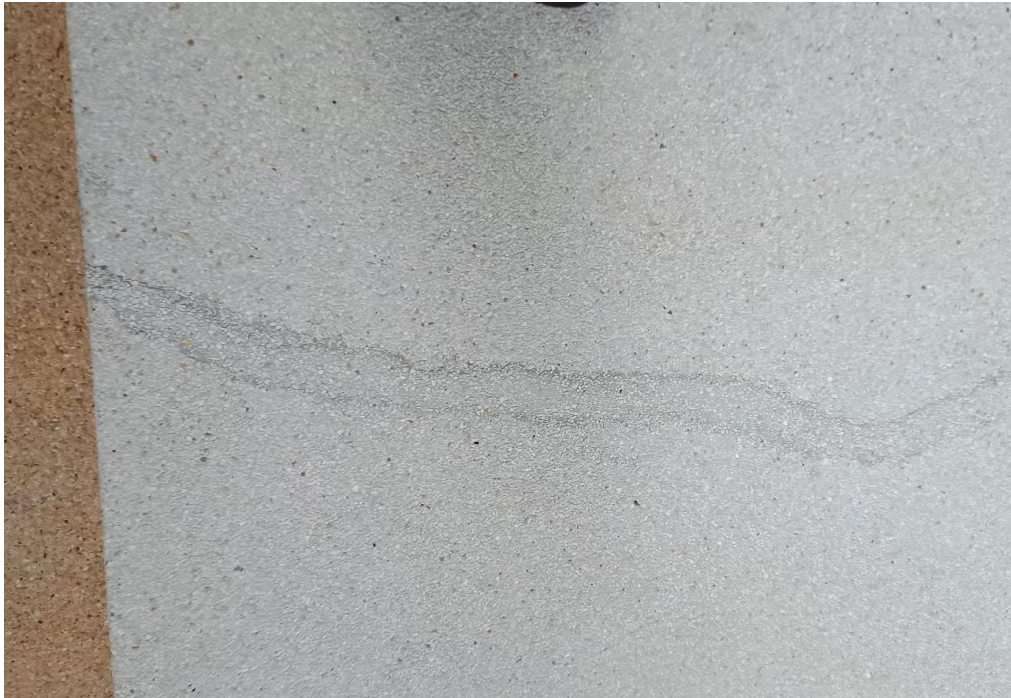
ซ่อมแซมพื้นที่มีปัญหา รอยแยก รอยแตก
