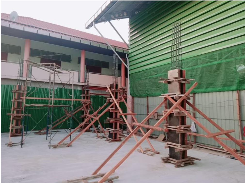
ดำเนินการก่อสร้างตึกอนุบาล
