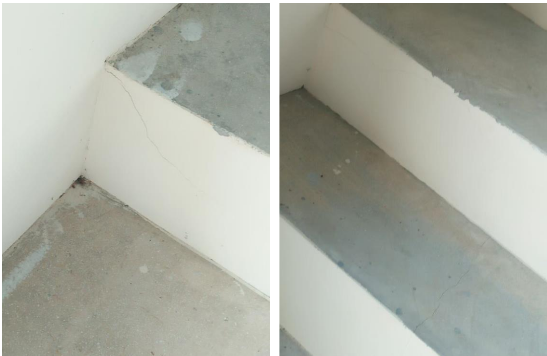
ซ่อมแซมบันไดที่มีปัญหาต่างๆ
