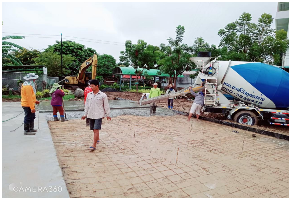
สร้างลานจอดรถ หลังโรงเรียนมารีย์อนุสรณ์
