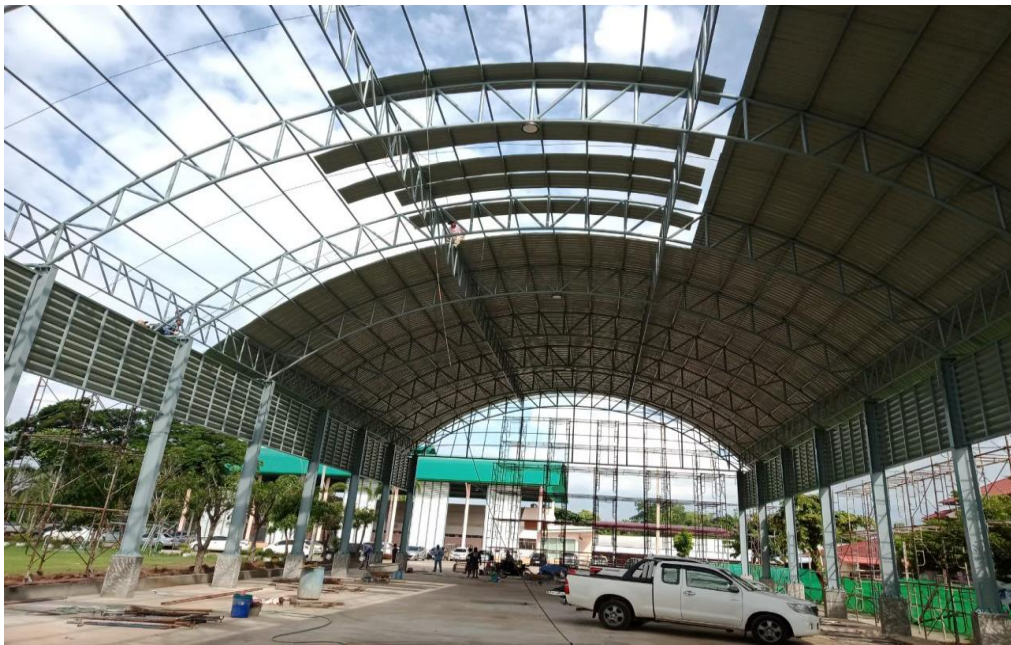
การก่อสร้างโดมใหม่ เซนต์ปีเตอร์โดม ของโรงเรียนมารีย์อนุสรณ์
