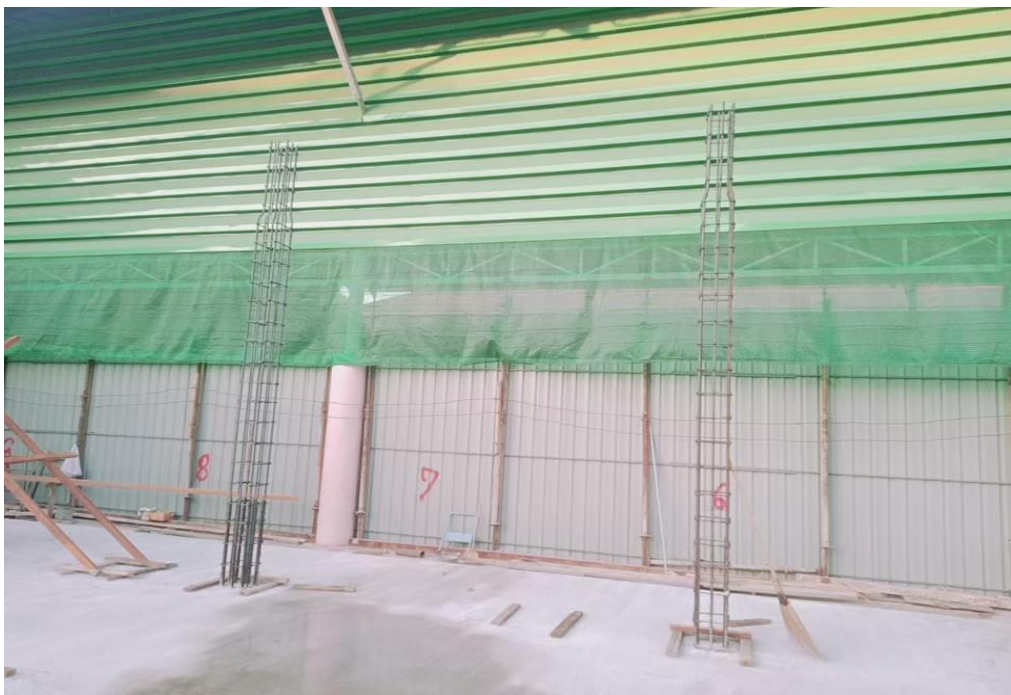
ดำเนินการก่อสร้างตึกอนุบาล
