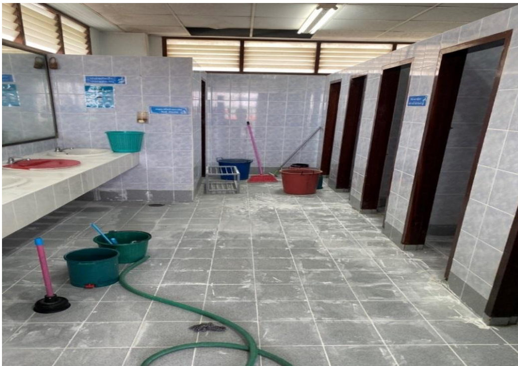
ซ่อมแซมห้องน้ำที่ชำรุดให้พร้อมใช้
