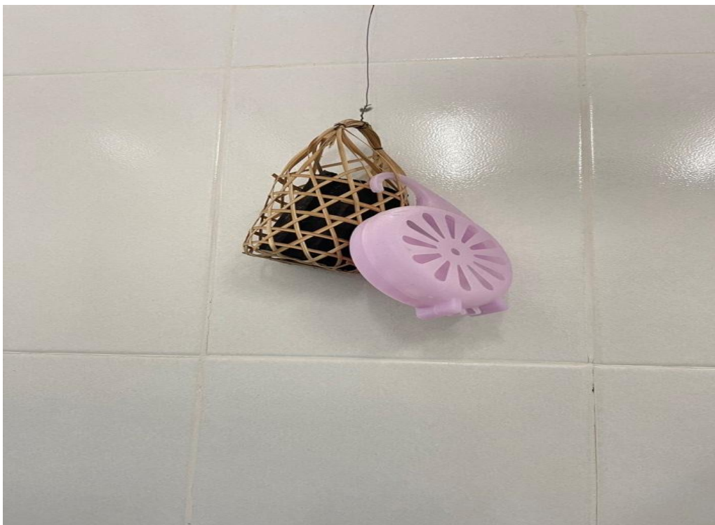
ติดตั้งอุปกรณ์ดับกลิ่นห้องน้ำที่สะดวกพร้อมแก่การใช้งาน
