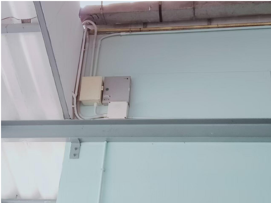
ติดตั้งกล่องไฟ/ควบคุมไฟกล่องวงจรปิด
