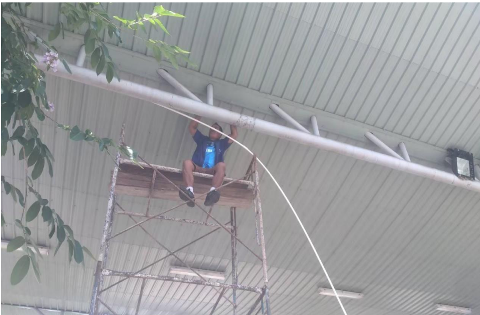
ติดตั้งสายแลนเพื่อแสกนบัตร
