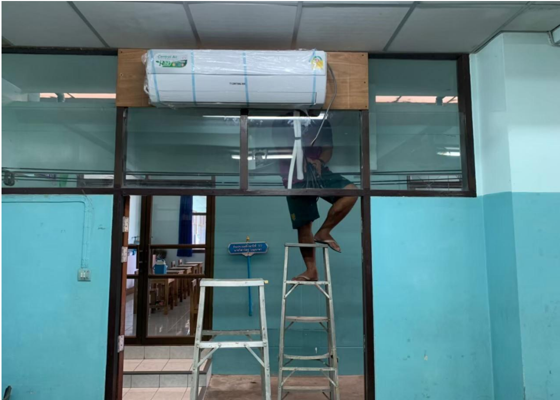
ทีมช่างซ่อมบำรุงติดตั้งเครื่องปรับอากาศ
