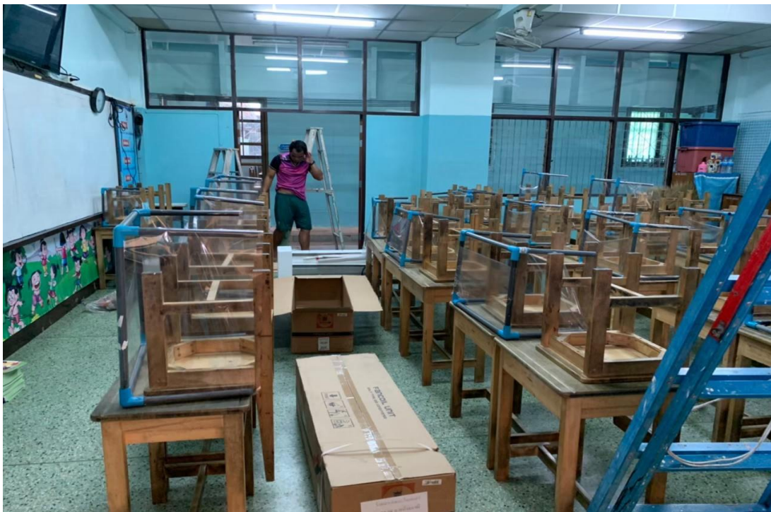
ทีมช่างซ่อมบำรุงติดตั้งเครื่องปรับอากาศ
