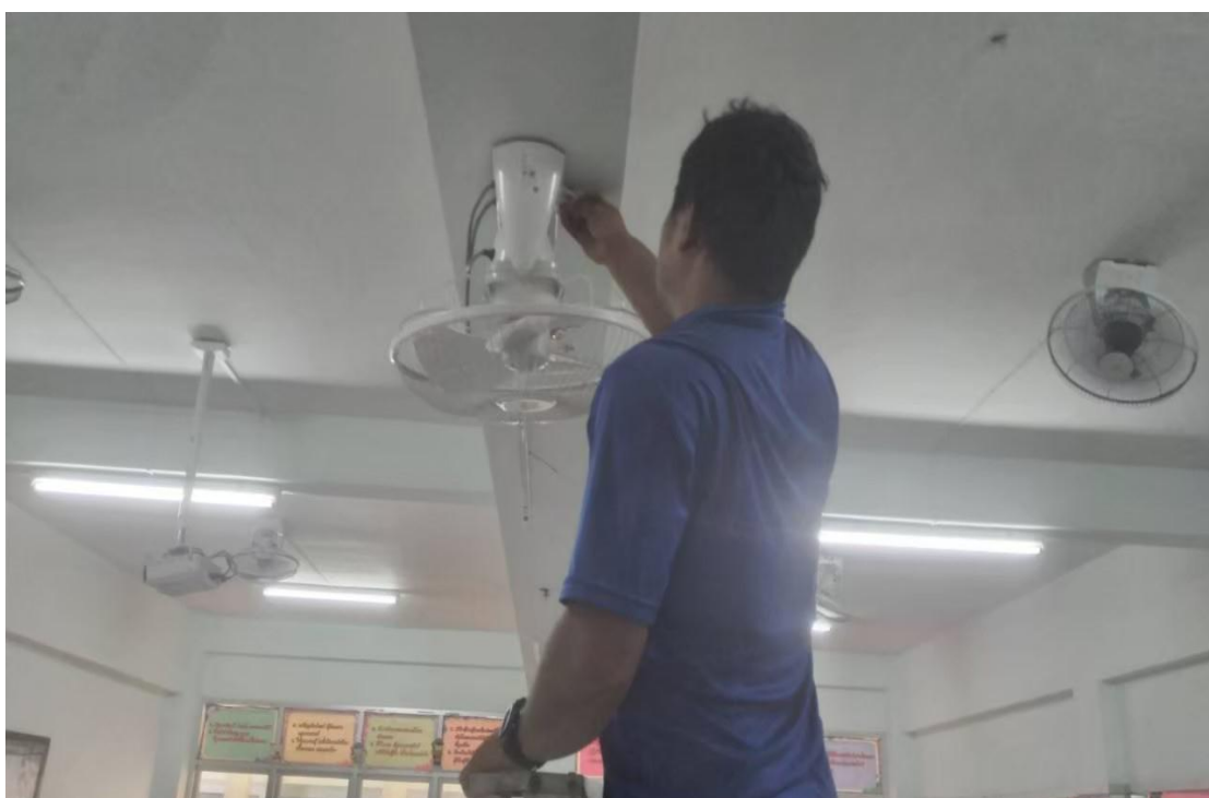
ทีมช่างติดตั้งพัดลม
