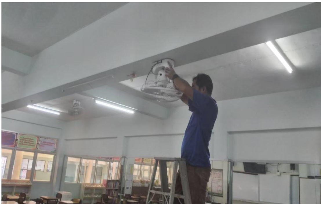
ทีมช่างติดตั้งพัดลม
