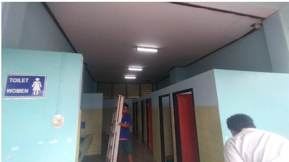
ทีมช่างซ่อมบำรุงหลอดไฟฟ้า
