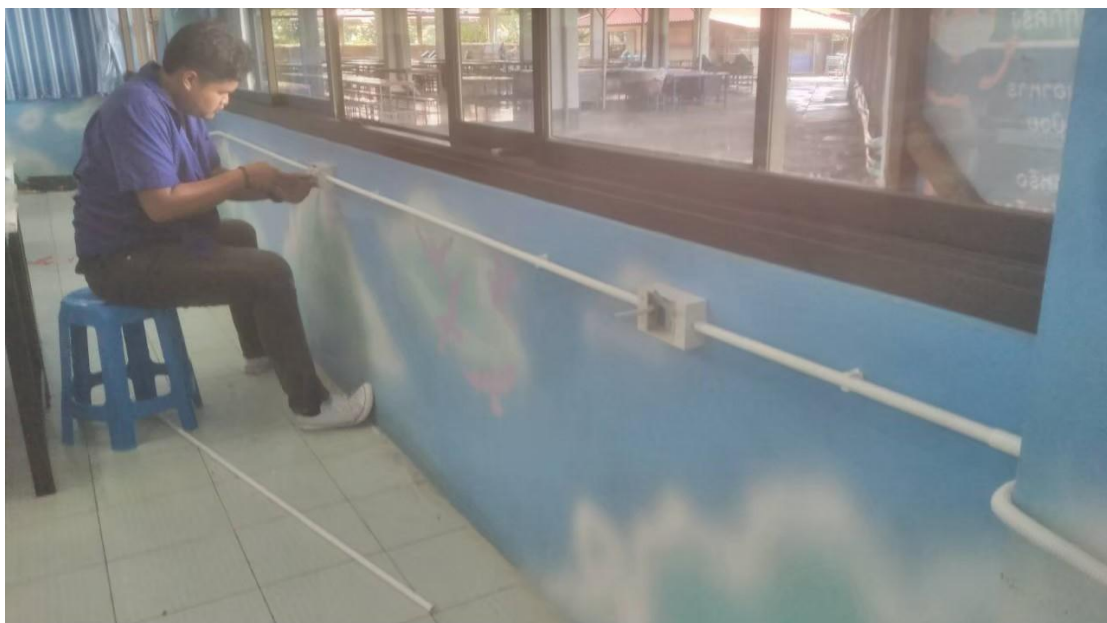
ทีมช่างติดตั้งสายไฟ
