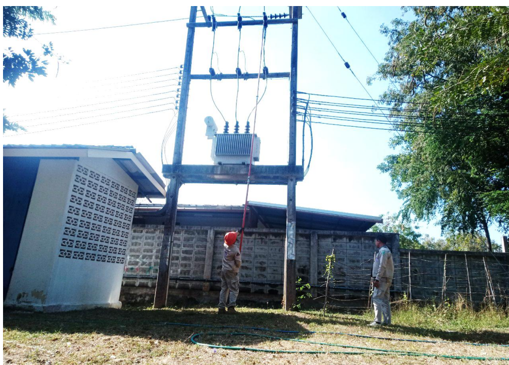
ทีมช่างซ่อมแซมหม้อแปลงไฟฟ้าโรงเรียนมารีย์อนุสรณ์
