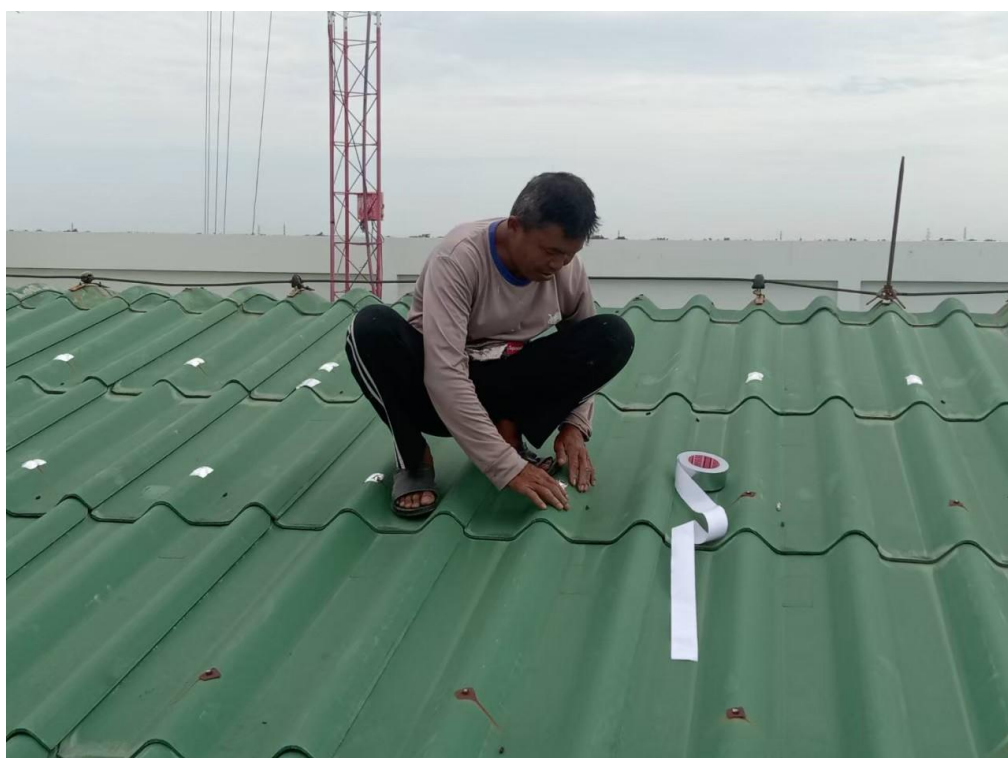
ทึมซ่งซ่อมหล้งคาคาที่ร้ว
