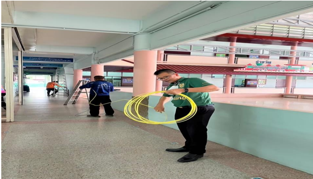
ทีมช่างติดตั้งระบบสัญญาณwifi
