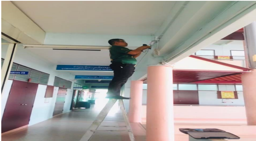
ทีมช่างติดตั้งระบบสัญญาณwifi
