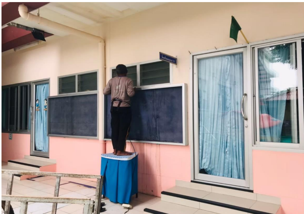
ทีมช่างซ่อมแซมกระจกบอร์ดคอนูบาล
