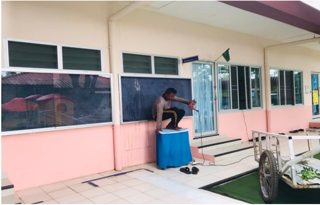
ทีมช่างซ่อมแซมกระจกบอร์ดคอนูบาล
