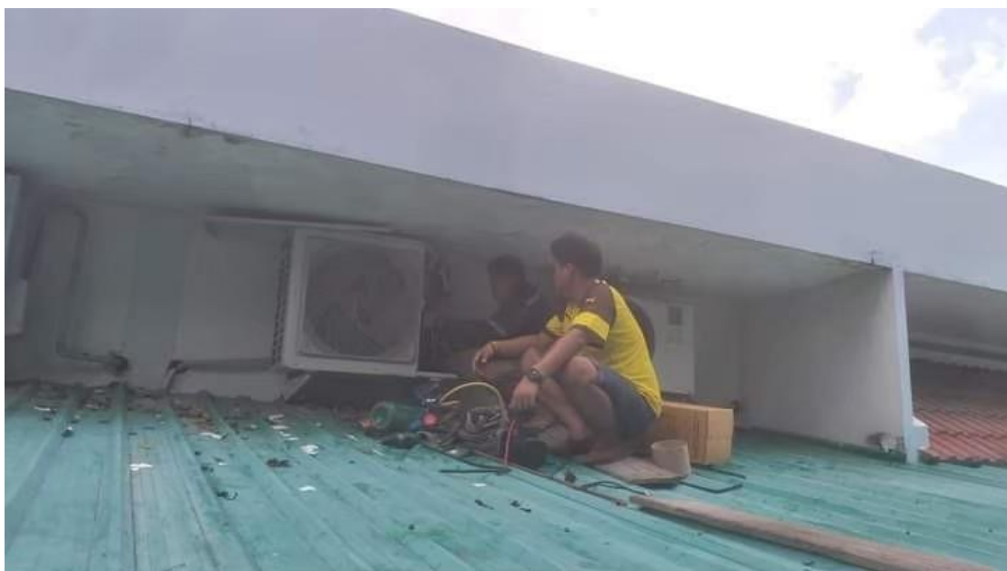
ทีมช่างซ่อมแซมแอร์
