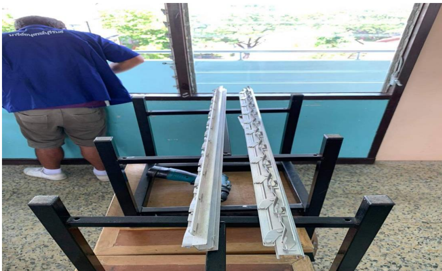
ทีมช่างซ่อมแซมบานเกร็ดหน้าต่างในห้องเรียน
