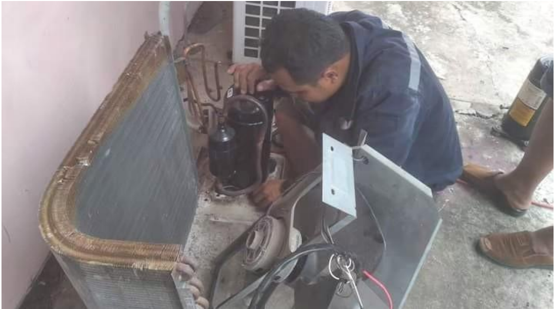
ทีมช่างซ่อมแซมคอมแอร์
