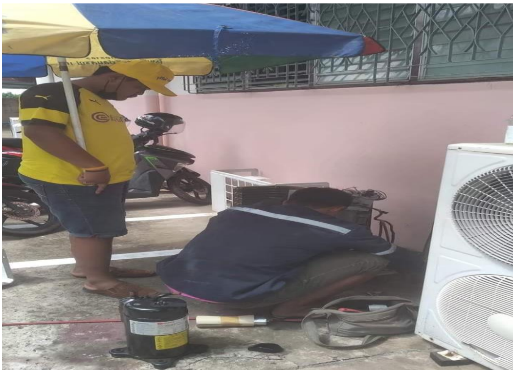
ทีมช่างซ่อมแซมคอมแอร์
