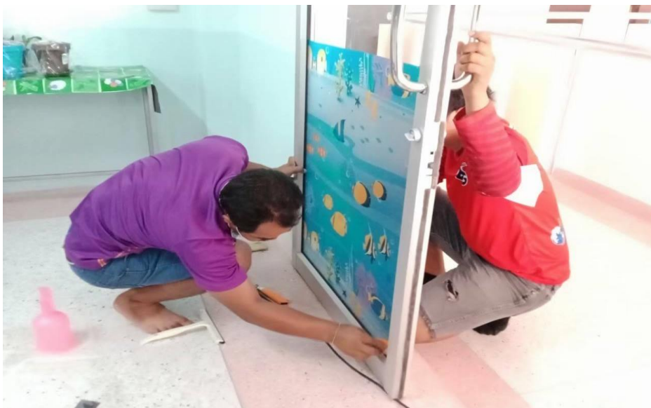
ทีมช่างติดตั้งเคอร์ประตูอาคารจอห์นปอลเพื่อความสวยงาม
