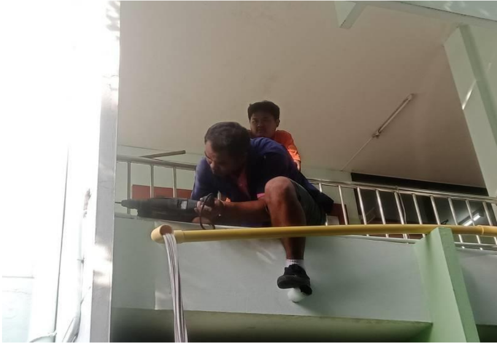
เดินสายสัญญาณระบบเสียง
