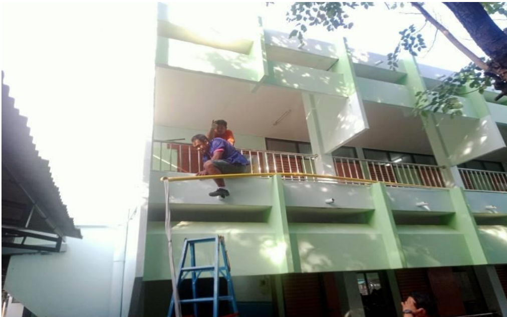
เดินสายสัญญาณระบบเสียง
