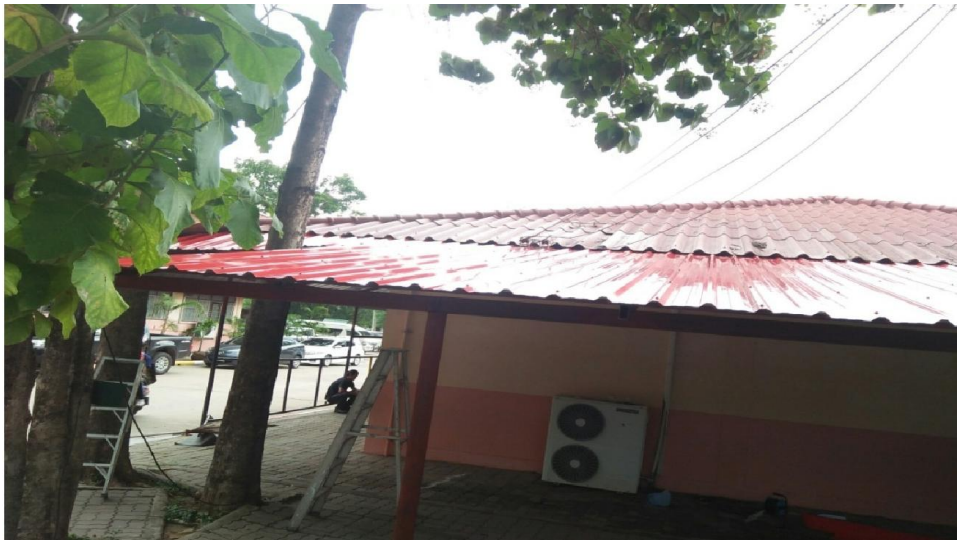
ต่อหลังคาข้างตึกอนุบาลเป็นลานจอดรถจักรยานยนต์
