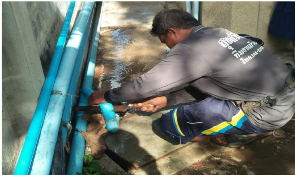
ซ่อมแซมท่อประปาจากเดิมเป็นท่อเหล็กที่อุดตันเป็นท่อพีวีซี
