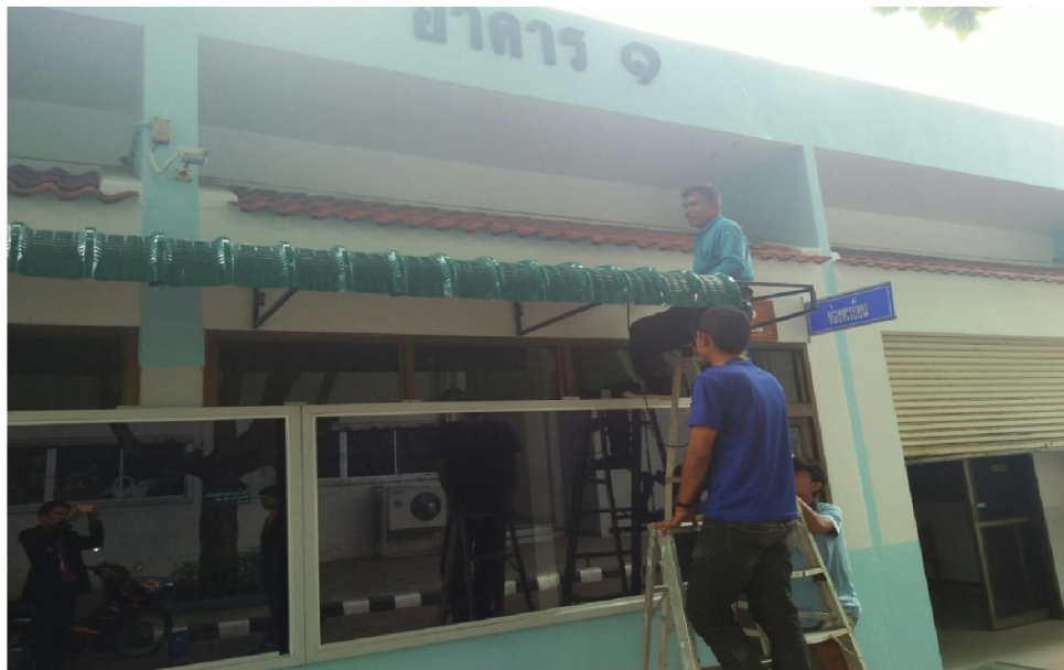
ติดตั้งกันสาด
