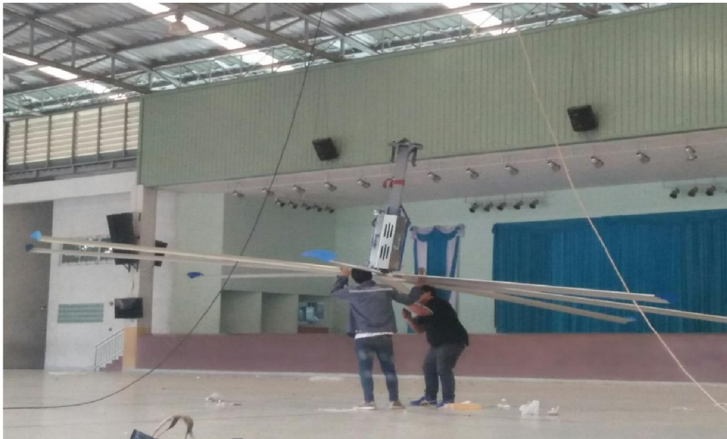
ติดตั้งพัดลมขนาดใหญ่ในอาคารแม่รีโดม
