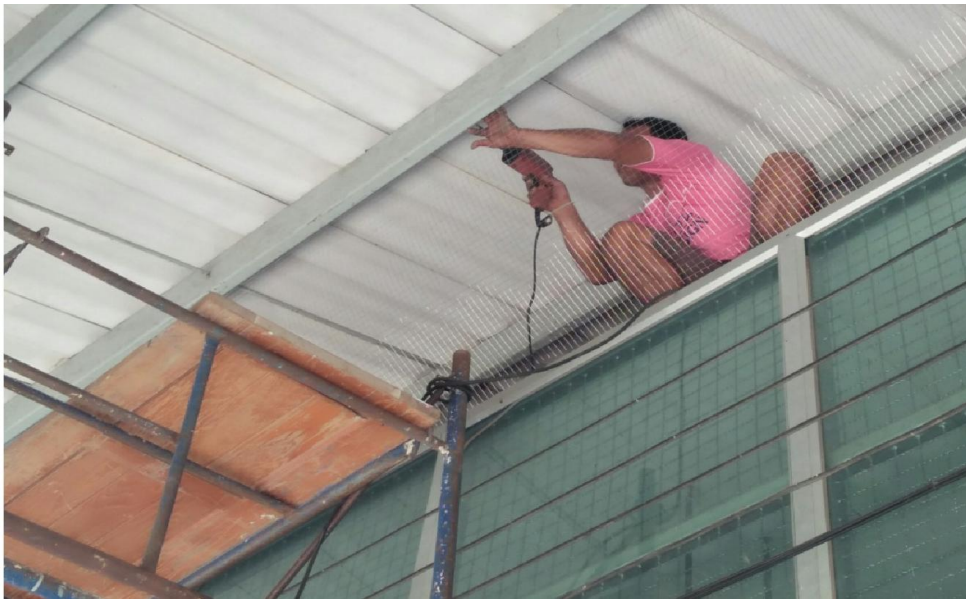
ติดตั้งตาข่ายลวดกันนก
