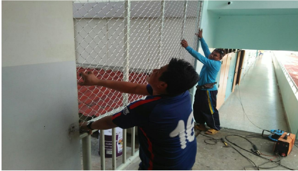
ติดตั้งตระแกรงช่องระหว่างตึก
