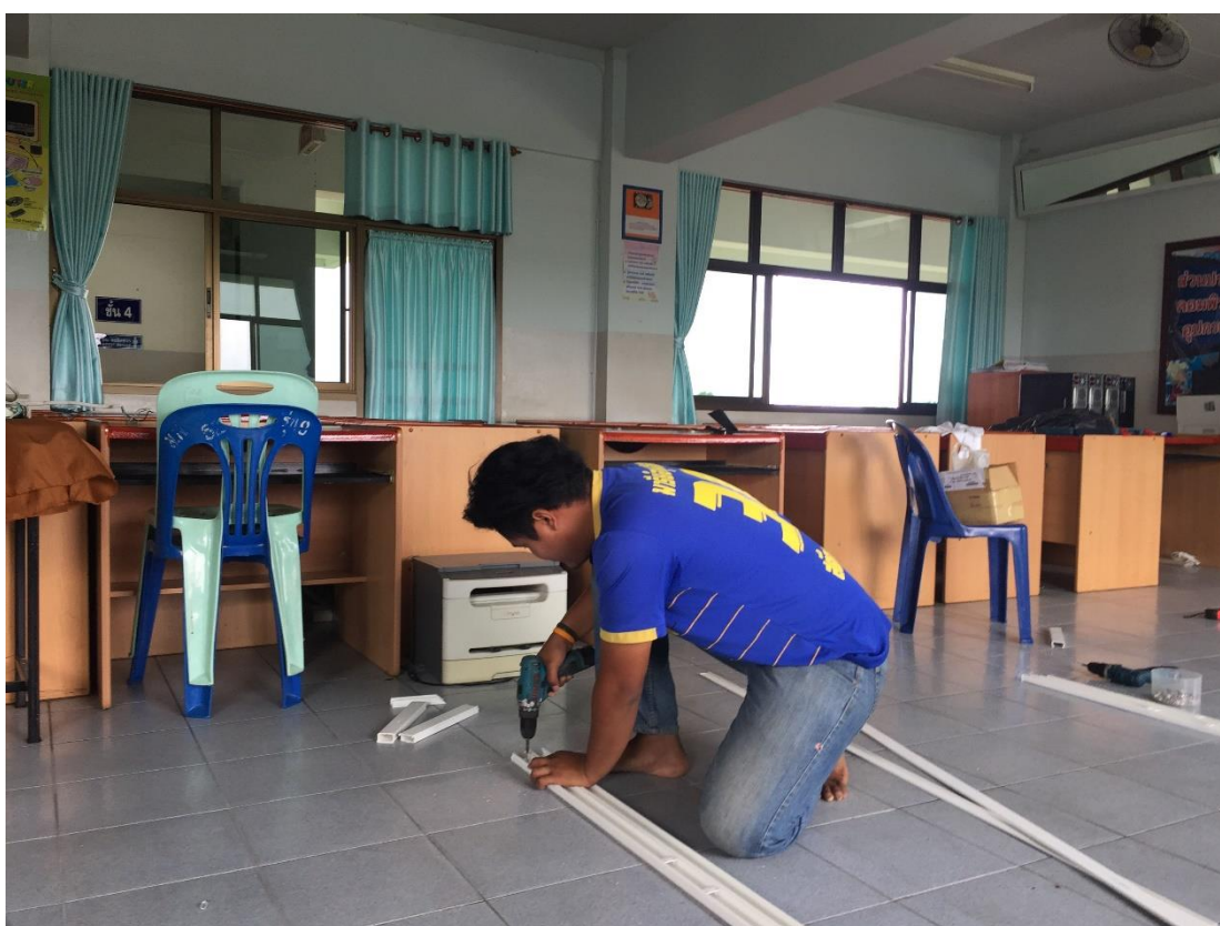
ติดตั้งระบบเครือข่าย (LAN) ภายในห้อง
