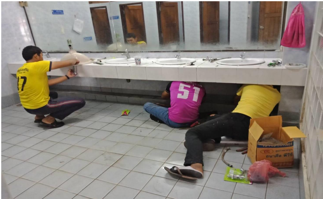
ทีมช่างซ่อมแซมท่อระบายน้ำอ่างล้างมือ
