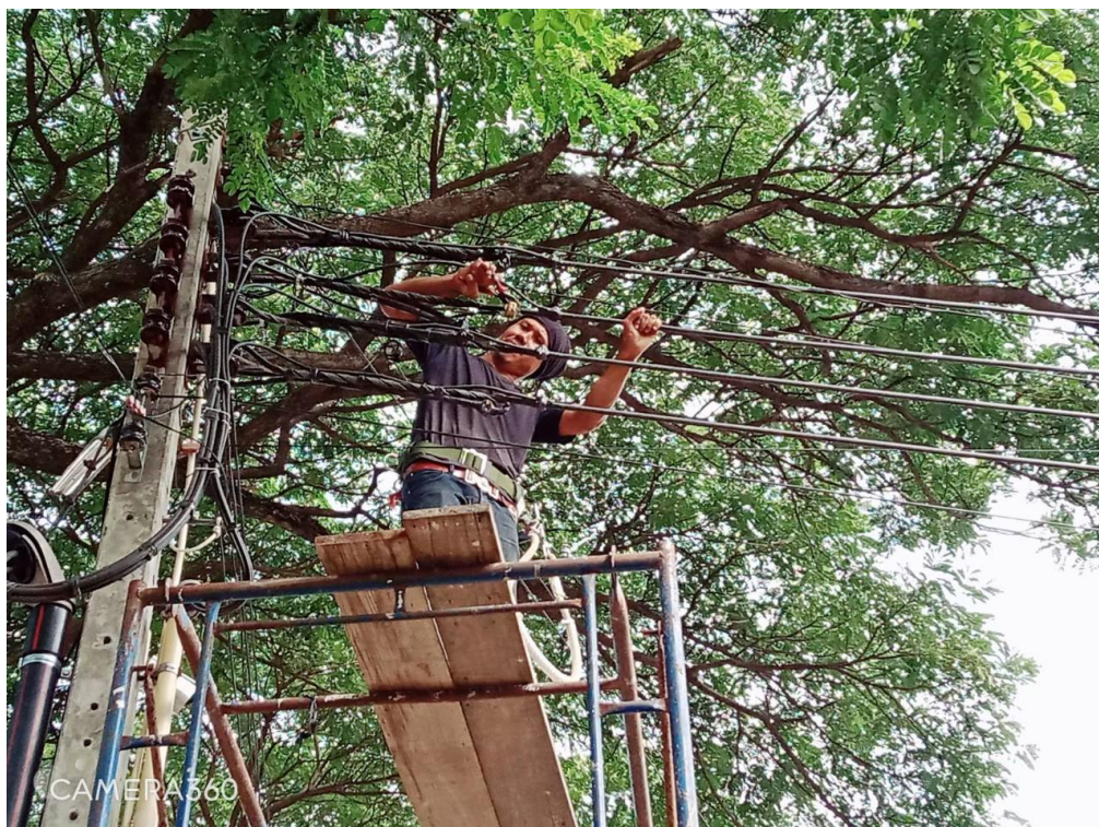
ทีมช่างซ่อมแซมสายไฟฟ้าที่ชำรุดภายนอกอาคารเรียน
