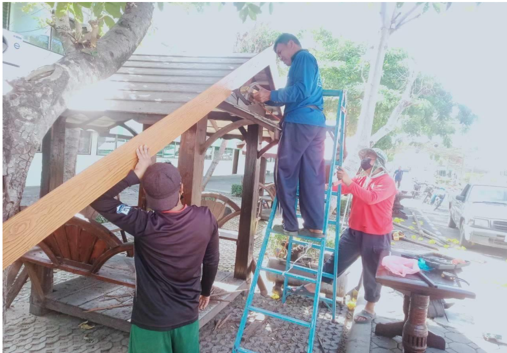
ทีมช่างซ่อมแซมซุ้มล้อเกวียนที่ชำรุด
