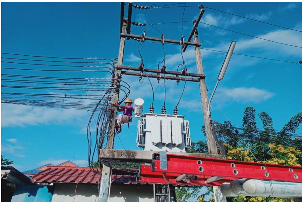
ทีมช่างซ่อมแซมหม้อแปลงไฟฟ้าโรงเรียนมารีย์อนุสรณ์
