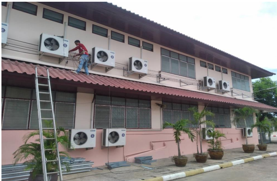
ทีมช่างซ่อมแซมสายไฟฟ้าที่ชำรุดรอบอาคารเรียน
