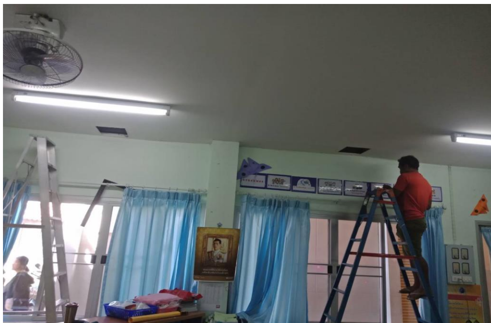
ทีมช่างซ่อมแซมผ้าเพดานในห้องเรียน
