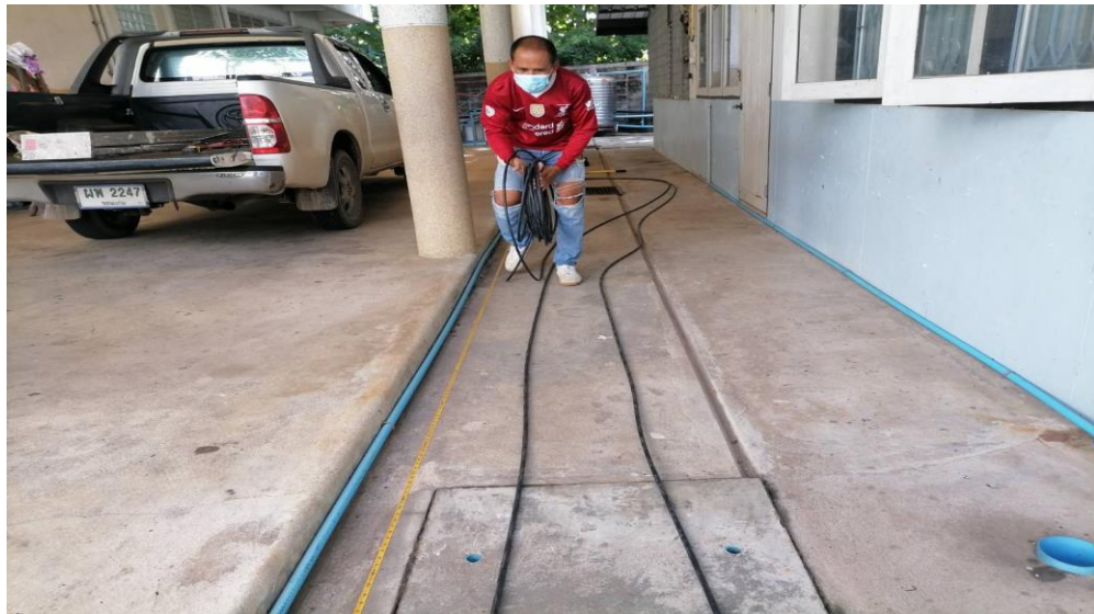
ทีมช่างติดตั้งและเดินสายไฟฟ้าบนอาคารเรียน
