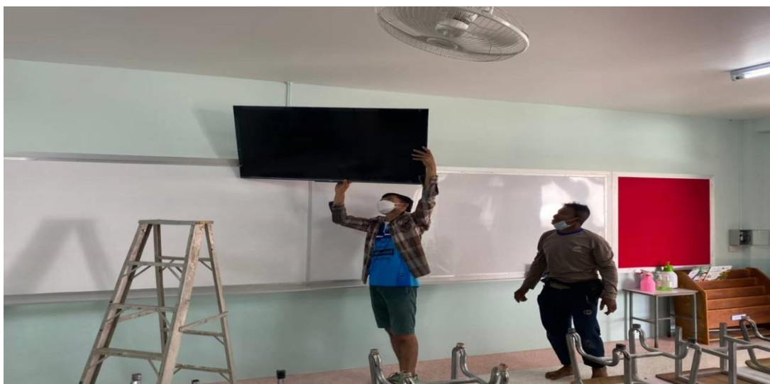
ทีมช่างติดตั้งทีวีห้องเรียนอนุบาล
