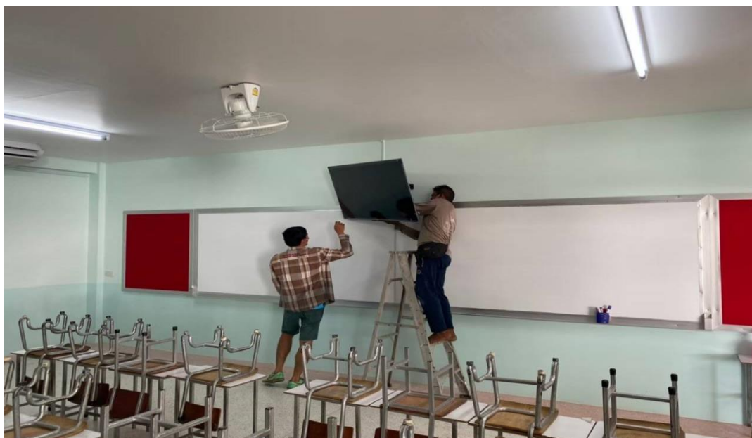
ทีมช่างติดตั้งทีวีห้องเรียนอนุบาล
