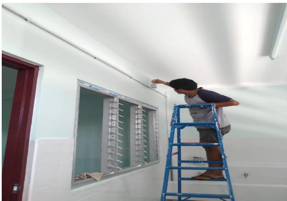
ทาสีเก็บรายละเอียดรางเดินสายไฟฟ้าภายในอาคาร
