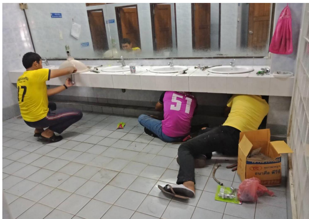
ทีมช่างซ่อมแซมท่อระบายน้ำอ่างล้างมือ
