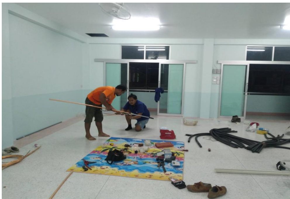
ทีมช่างเตรียมติดตั้งเครื่องปรับอากาศภายในห้องเรียนอาคารใหม่อนุบาล
