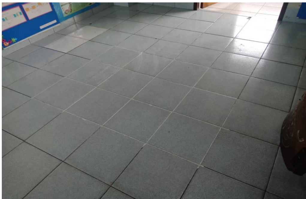
ทิมช่างซ่อมแซมพื้นกระเบื้องที่ชำรุดในห้องเรียน
