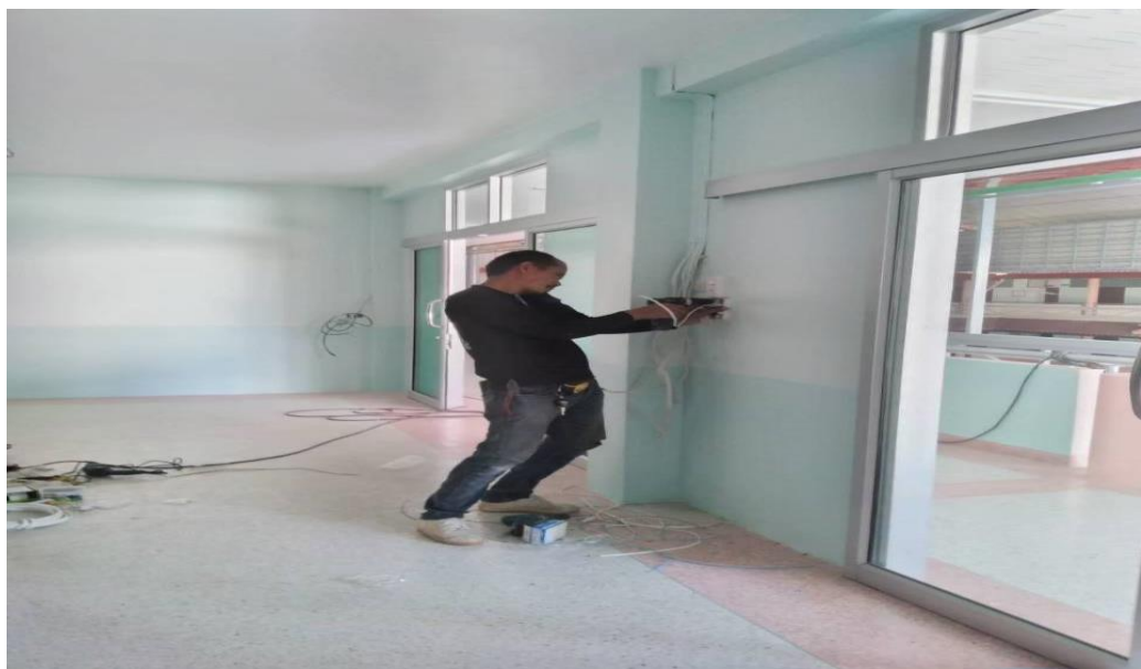
ทีมช่างติดตั้งปลั๊กไฟฟ้าห้องเรียนอาคารใหม่อนุบาล
