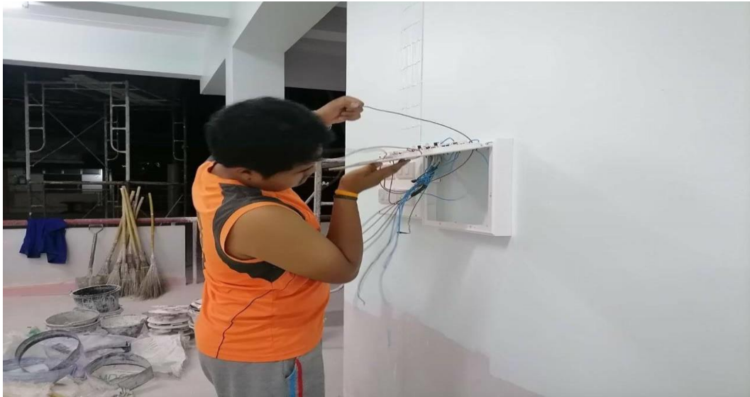
ทีมช่างติดตั้งปลั๊กไฟฟ้าห้องเรียนอาคารใหม่อนุบาล
