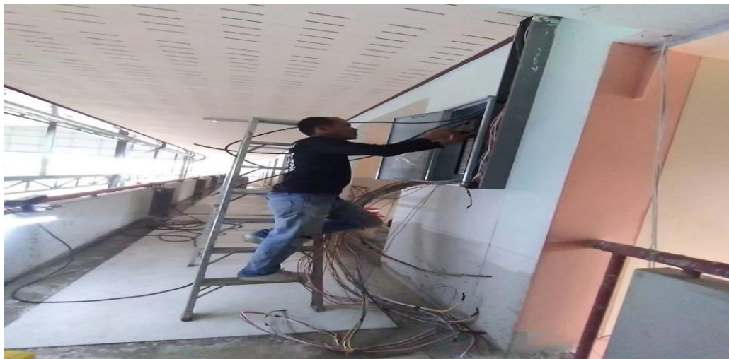
ทีมช่างติดตั้งเบรกเกอร์ไฟฟ้าอาคารใหม่อนุบาล
