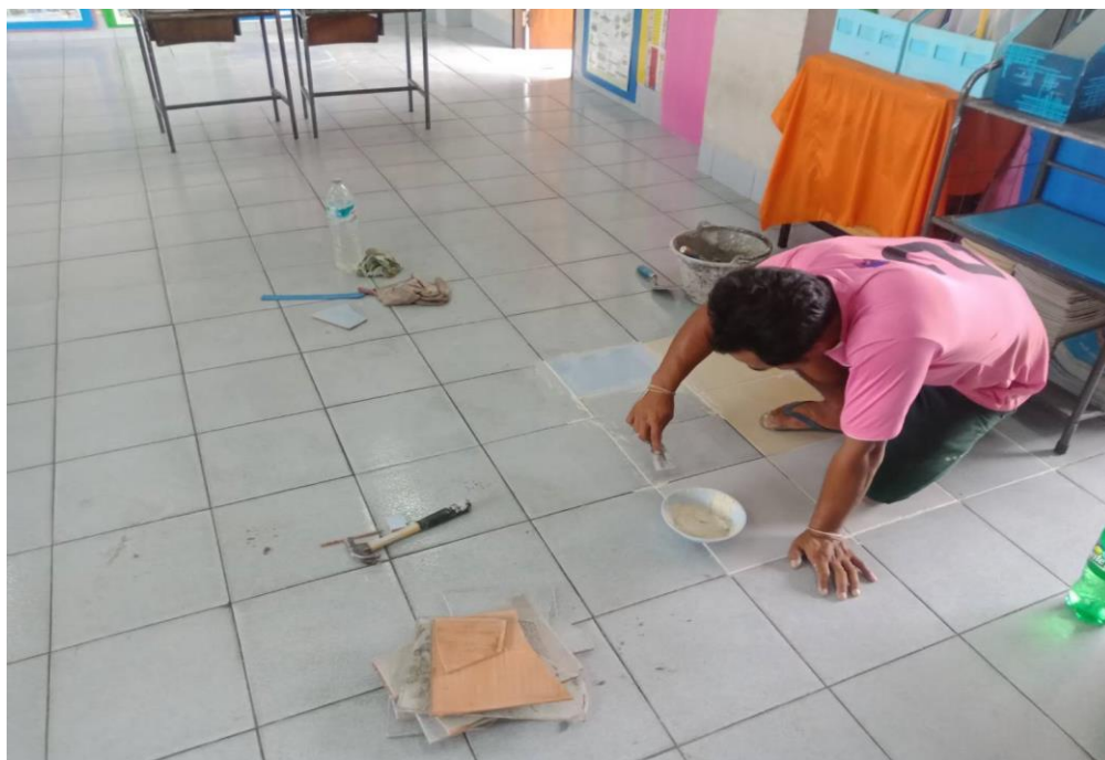
ทิมช่างซ่อมแซมพื้นกระเบื้องที่ชำรุดในห้องเรียน
