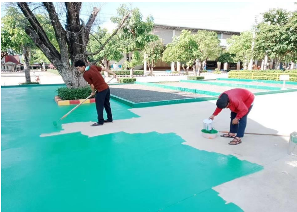
ทาสีพื้นลานข้างโดมเซนปีเตอร์โดมโรงเรียนมารีย์อนุสรณ์
