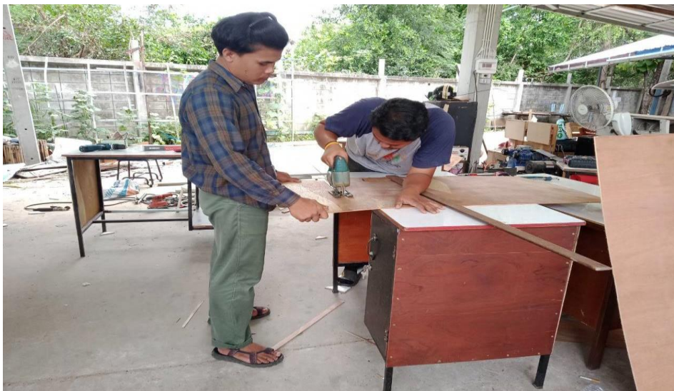
ทีมช่างซ่อมแซมโต๊ะครูที่ชำรุด
