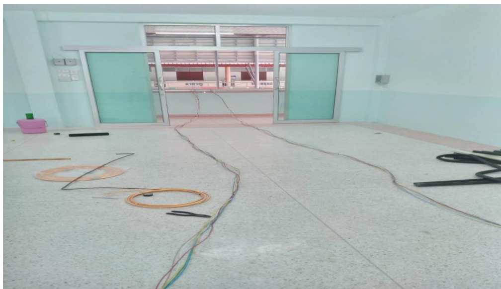
ทีมช่างเตรียมติดตั้งสายไฟฟ้าอาคารอนุบาล
