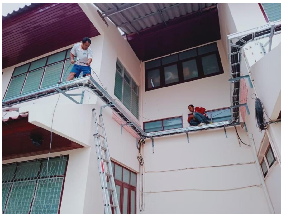
เจ้าหน้าที่ติดตั้งสาย อินเทอร์เน็ตรอบอาคารเรียน
