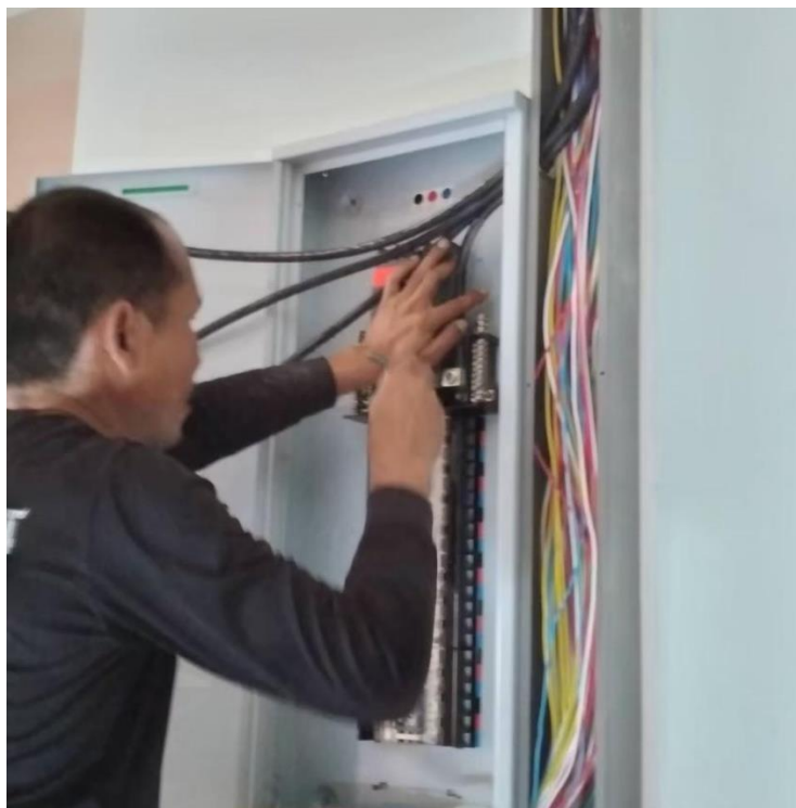
ติดตั้งสาย อินเทอร์เน็ตอาคารเรียนหลังใหม่
