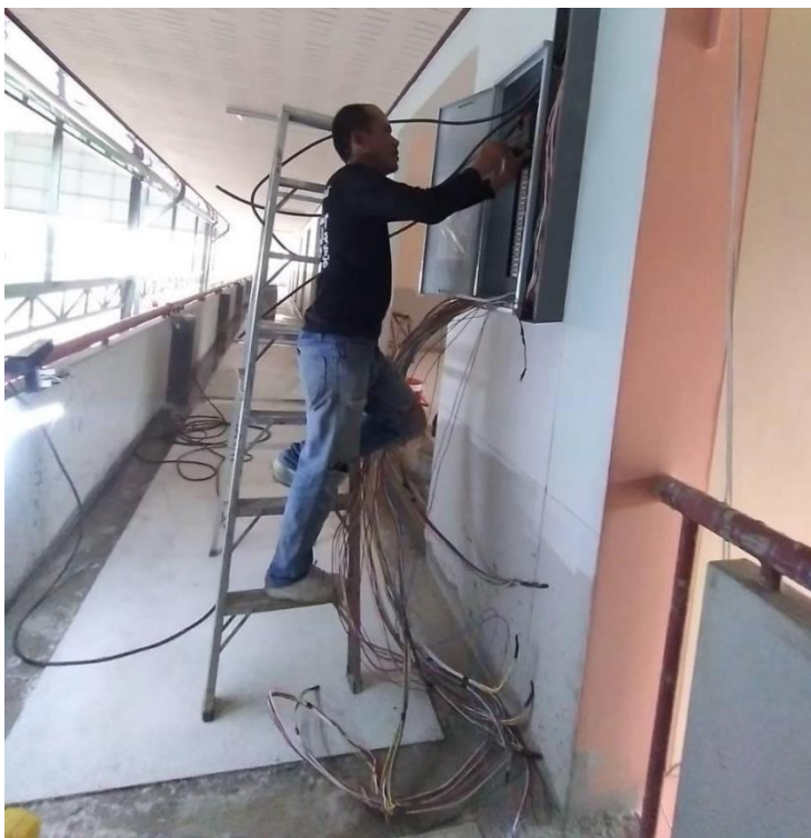
ติดตั้งสาย อินเทอร์เน็ตอาคารเรียนหลังใหม่
