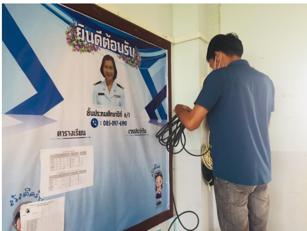
จัดเก็บงานให้เรียบร้อยหลังติดตั้งและเปลี่ยนสาย HDMI
