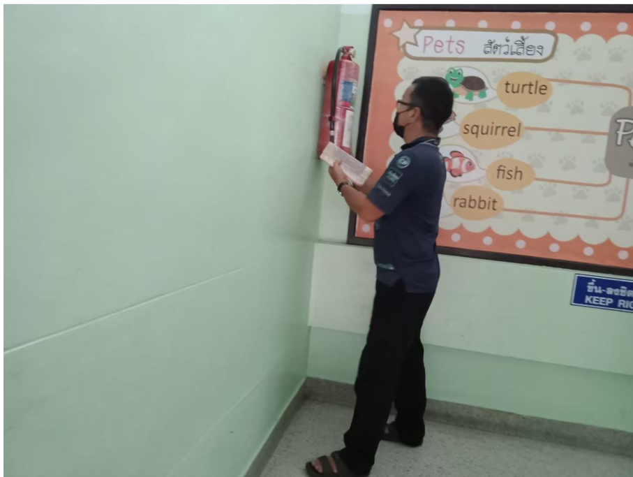
ติดตั้งถังน้ำยาดับดับเพลิงใหม่พร้อมบันทึกอายุการใช้งาน
