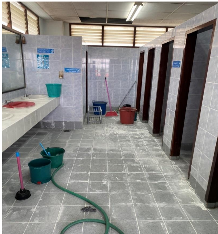
ซ่อมแซมห้องน้ำให้พร้อมใช้เสมอ
